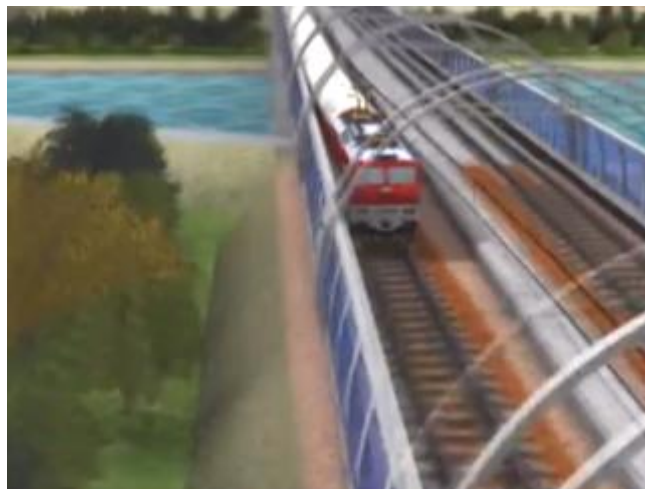
Vytvorenie betónového valu pod koľajiskom vytvorí novú vyššiu bariéru v meste
