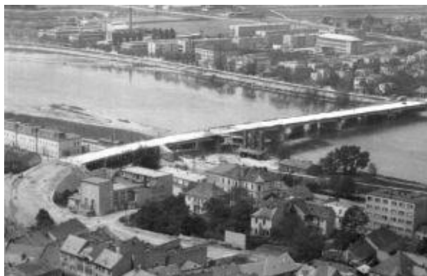
Výstavba súčasného cestného mosta, r. 1953.
