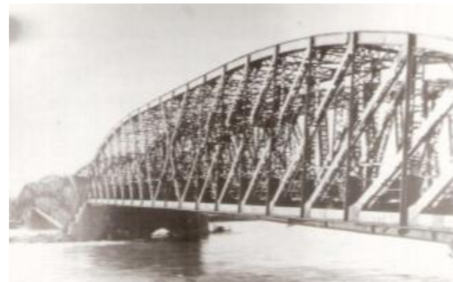
Zničený most cez Váh v Trenčíne
